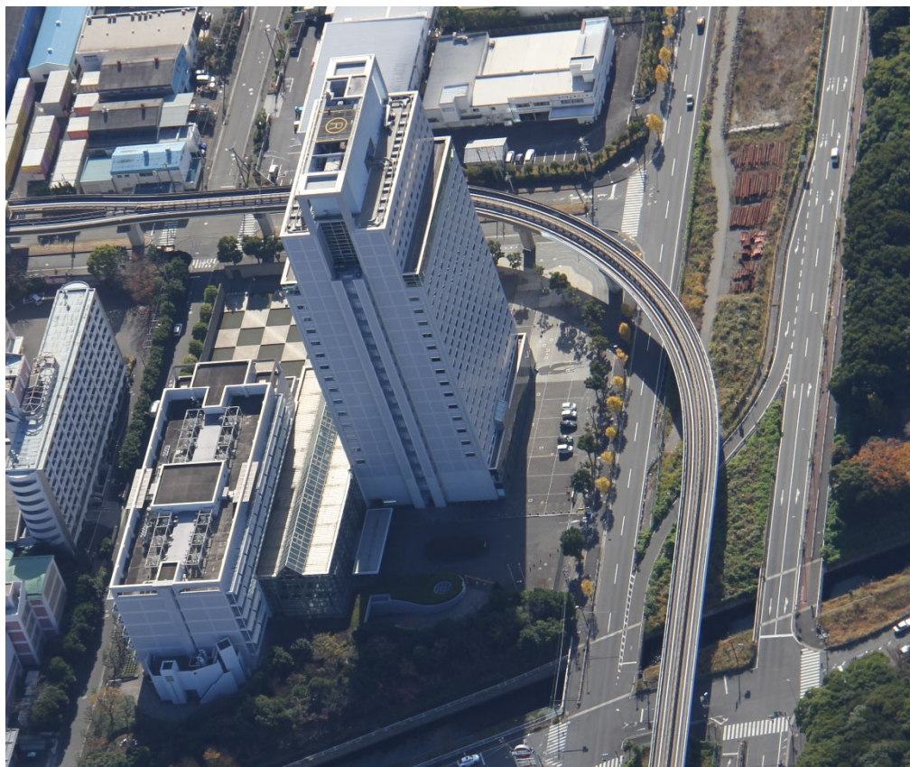
北側上空から撮影（令和5年12月）
